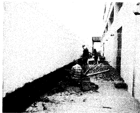
Fig. 11. Reposición de Zócalo
